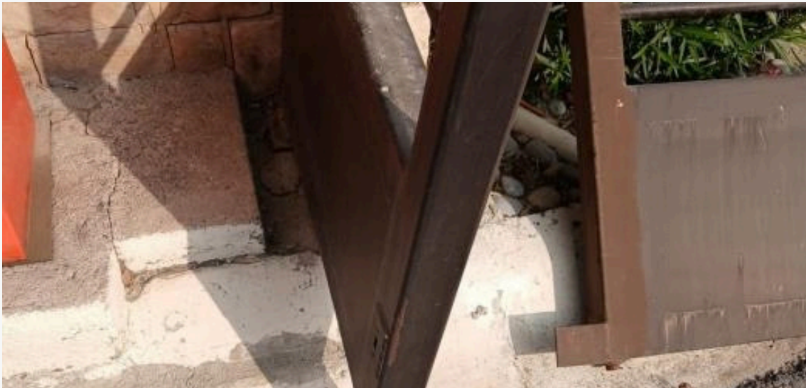
Reparaciones en inmuebles
