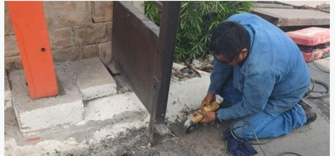
Trabajos en sitio
